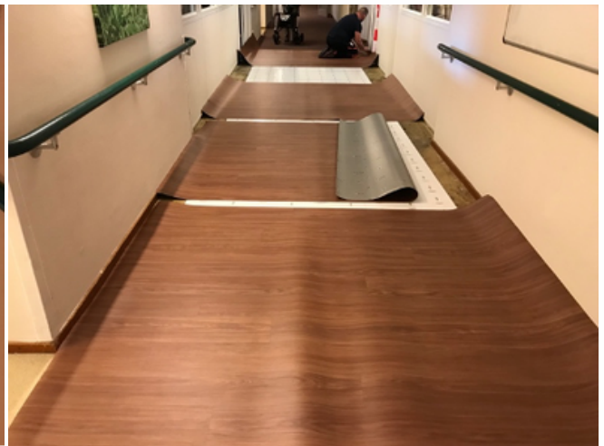
Afbeelding 4. Aanbrengen vloer over sensofolie
